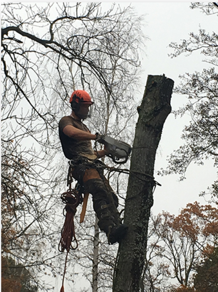
Bild 5: Under röjningarnas gång i etapp 2. Vissa träd kunde bara tas ner efter stegvis kapning av arborister.
